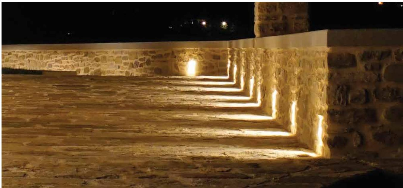
Incasso in alluminio tornito per illuminazione d'accento, decorazione, cortesia o emergenza. Illuminazione diffusa, installabile in ambienti interni ed esterni. Montaggio su cartongesso o laterizio con cassaforma.
